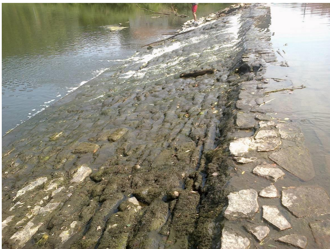
Obr. 10 Přelivná hrana – patrné vypadané kameny, povodní strana jezu
