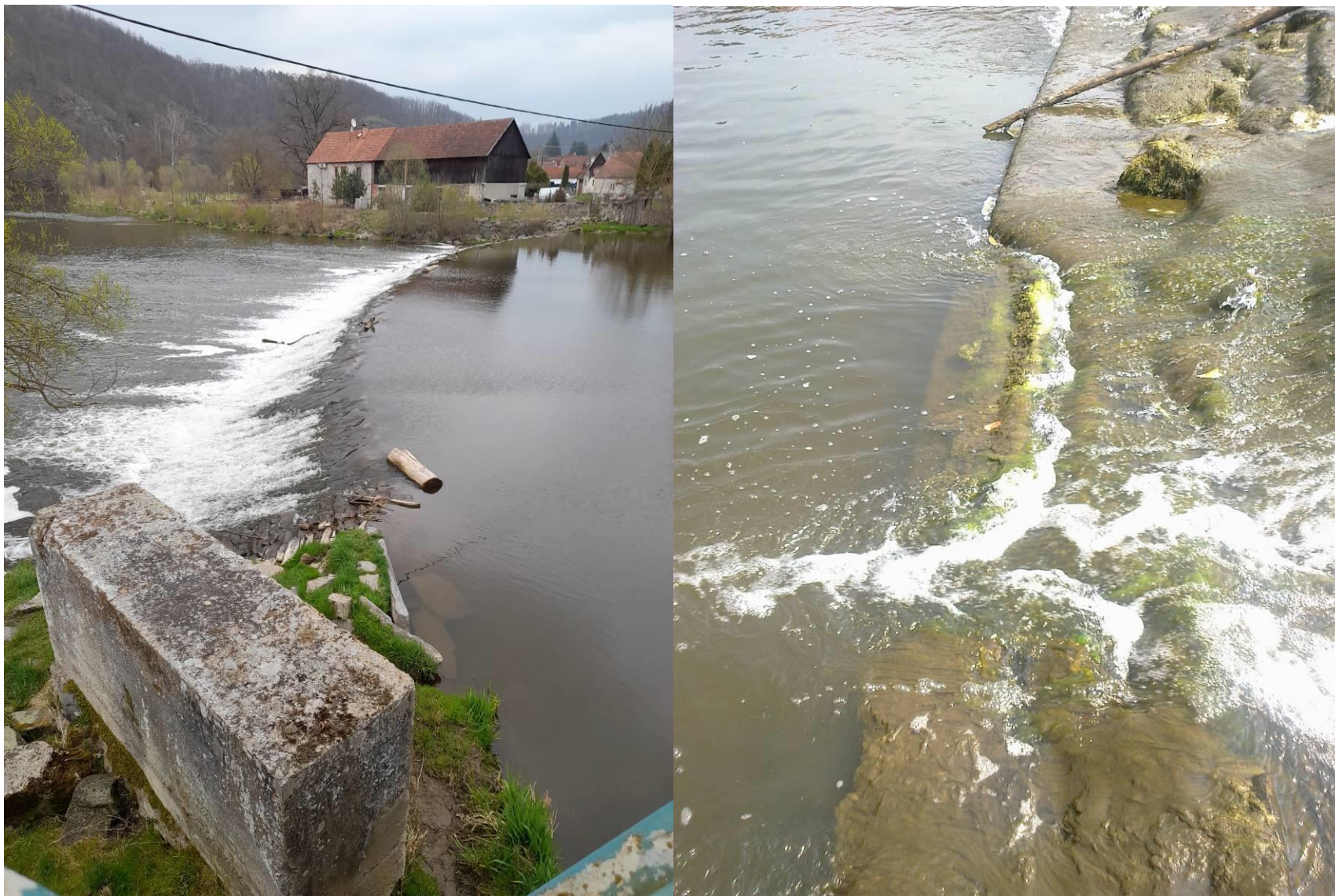
Obr. 2 Pilř bývalé lávky v levobřeží (vlevo), detail opěrné zdi v nadjezí (vpravo)
