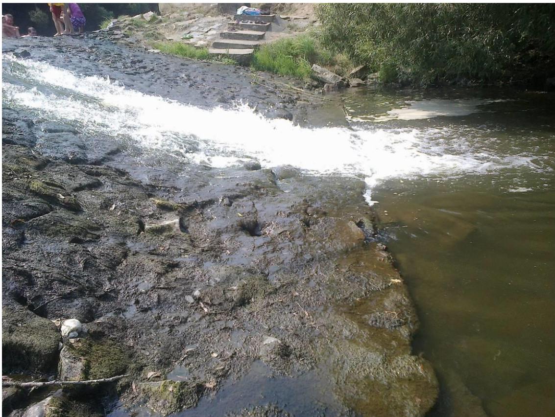
Obr. 7 Detail betonového prahu – výrazné poškození v levobřeží
