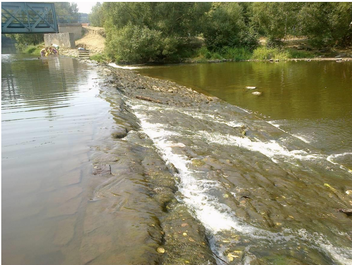
Obr. 8 Prosedlé části přelivné hrany
